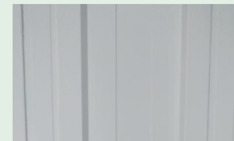
施工後1年4ヵ月経過後もカビが発生していない
